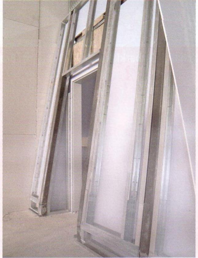
Bauphase II. Im Bild ist die ausgefachte Stahlzelle zu sehen, links schiebt sich die Tüorzarge ins Bild.
