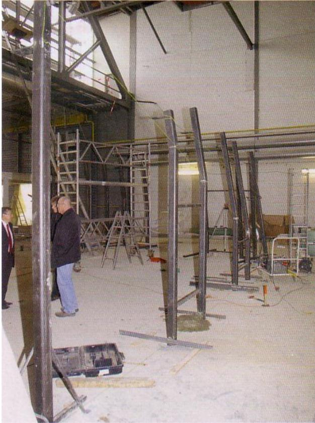
Bauphase I. Die von dem Stahlbauer entworfenen Stahlstützen sind aufgestellt und im Boden verankert. Die aussteifenden Elemente fehlen noch.
