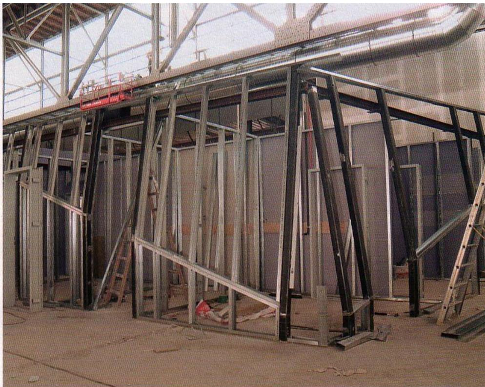
Bauphase III. Der Ausbau der großen Raumzelle, einschließlich der Toilettenräume ist eine Leichtbaukonstruktion, so dass die Raumzelle bei Bedarf auch umgehend wieder rückgebaut werden könnte.
